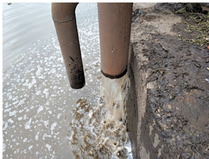
Рис. 6. Осветлённая вода на выходе из фильтровального модуля
